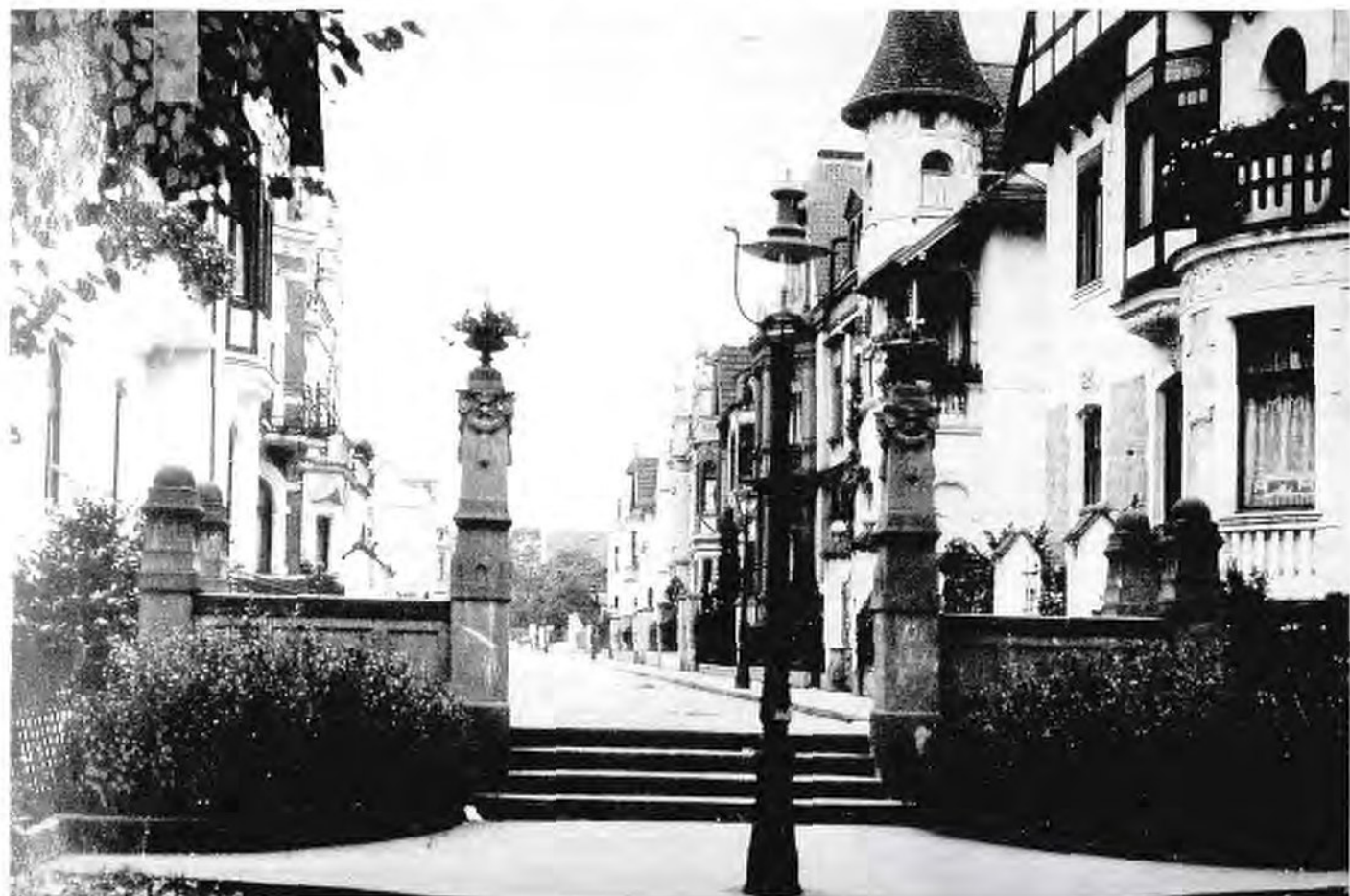
Die Gartenstraße im ursprünglichen Zustand.
